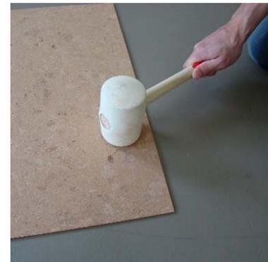
7. Belag passgerecht einlegen, mit einem Gummihammer gut festklopfen, so dass eine Filmverschmelzung erreicht wird.
